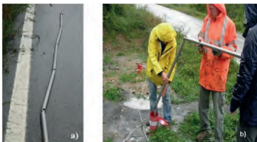
Fig. 2 - Sistema montato pronto per essere installato: a) tubo snodato, b) in fase di posa nel terreno.
