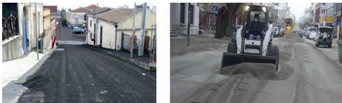
Fig. 4 - Impatto della cenere vulcanica sulla capacità di drenare piene urbane (eruzione dell'Etna).
