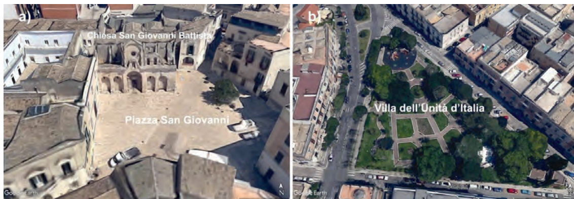
Fig. 3 - Aree di indagine nella città di Matera: a) Piazza San Giovanni e Chiesa di San Giovanni Battista; b) Villa dell'Unità d'Italia.
